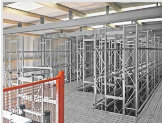
Reifenregalanlage System GENIUS, 1-geschossig
