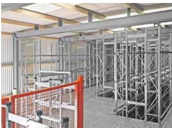
Reifenlagerhalle mit Regalanlage & Einsäulenlift
