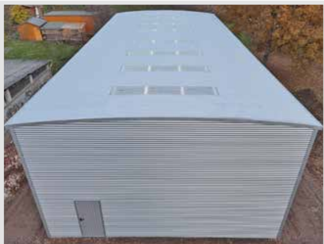
Flachdachhalle 9x20 m Höhe 5,00 m Traufe / 5,25 First
